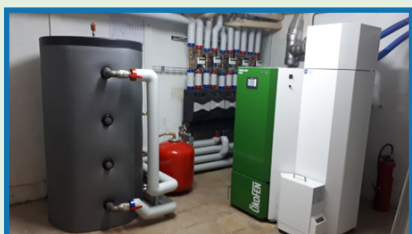
LA NOUVELLE CHAUFFERIE BOIS
